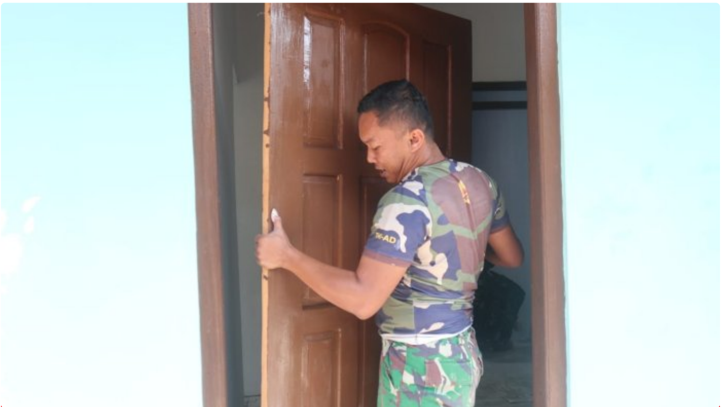
( Foto istimewa) pemasangan pintu RTLH
